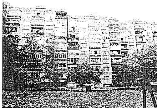
Жилищният блок е на 8 етажа с едно подземно ниво и покривна конструкция тип „студен покрив“. Сградата е едропанелна, изградена на буквата „Г“, със седем секции долепени една до друга.
